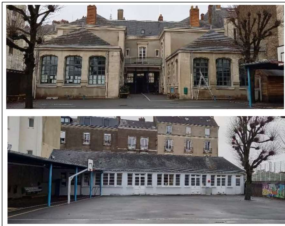
Figure 3.: Vues sur les bâtiments anciens et la salle de restauration actuelle en fond de cour.
